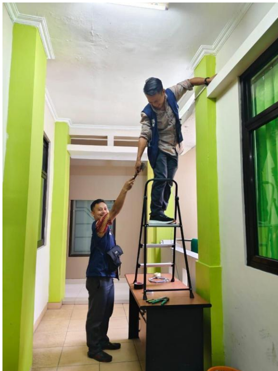
Gambar 15. Gambar Proses penarikan kabel
