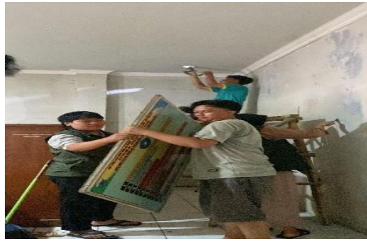
Gambar 16. Pembersihan Kantor Desa Cipicung.
