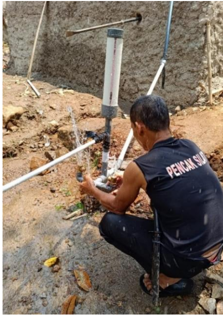
Gambar 10. Proses Pemasangan Pompa Hidram.
