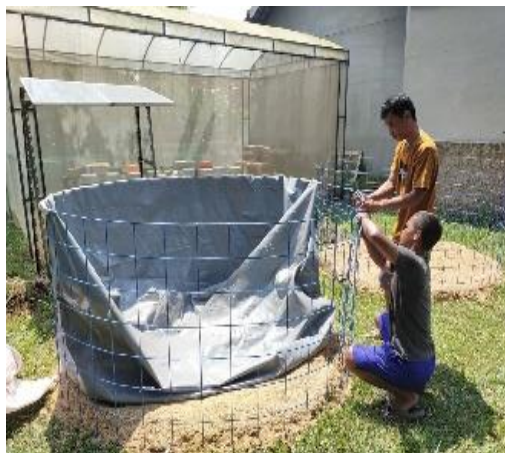
Gambar 4. Instalasi listrik dan kolam bioflok
