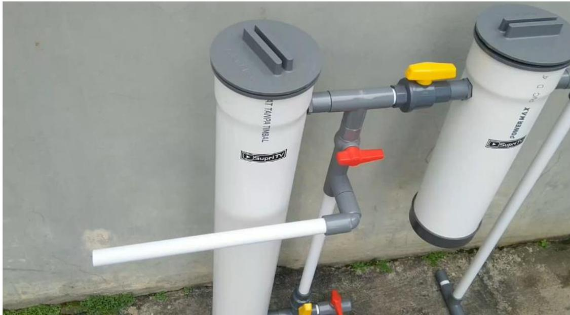
**Gambar 2.** Tabung Filter dan Sedimen Filter
