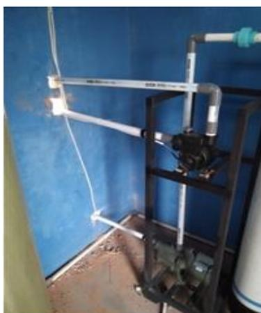
**Gambar 4.** Instalasi Pompa Filtrasi dan Aerasi
