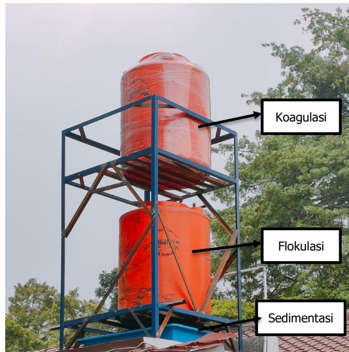
**Gambar 3.** Alat Pengolahan Air Tanah dengan Proses Koagulasi, Flokulasi, dan Sedimentasi di MCK RW 01 Kelurahan Kota Bambu Selatan
