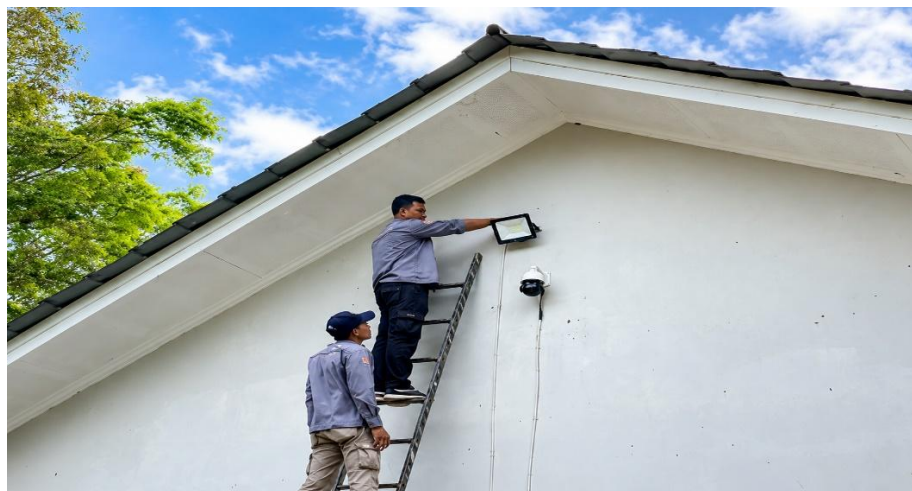
Gambar 4. Proses Pemasangan Lampu LED dan Sensor Photo Cell di Lingkungan Sekolah
