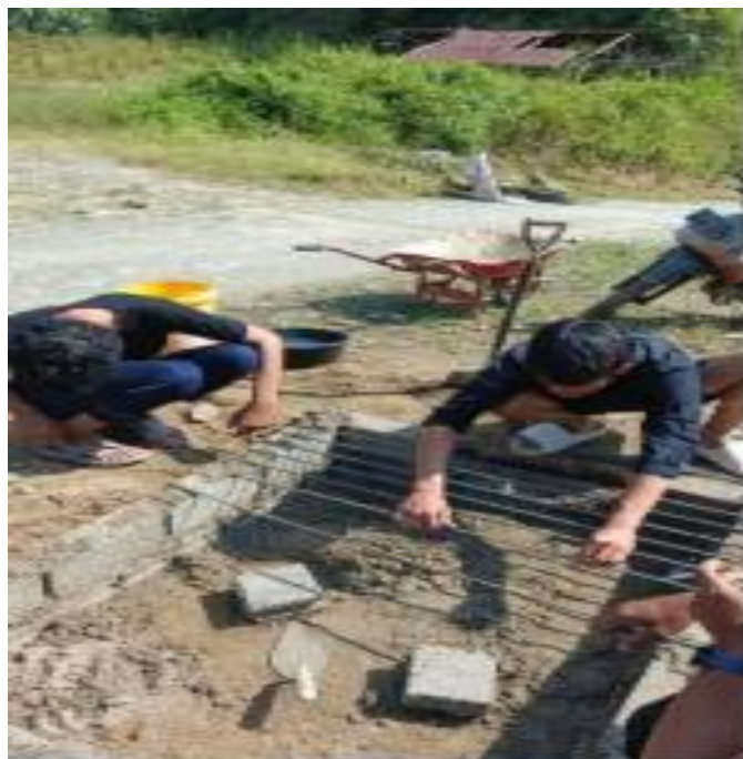
Gambar 1. Proses pembangunan rocket stove di Jorong Batang Pamo, Nagari Pianggu
