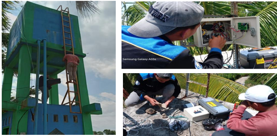
Gambar 2. Instalasi alat monitoring kualitas air pada menara air SPAM Desa
