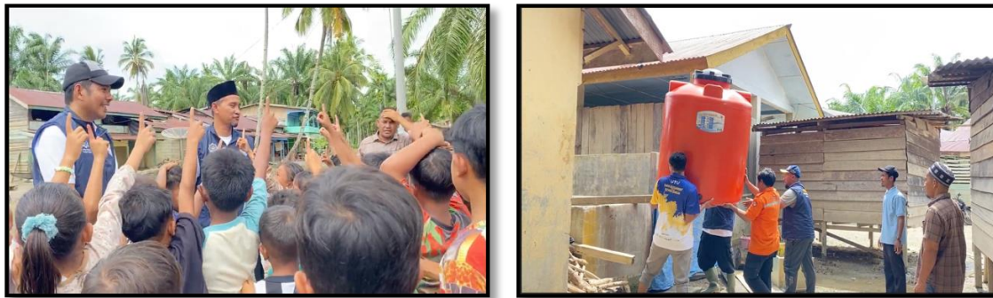
Gambar 4. Kegiatan pemulihan psikososial dan instalasi pengaliran air bersih di desa yang terdampak
