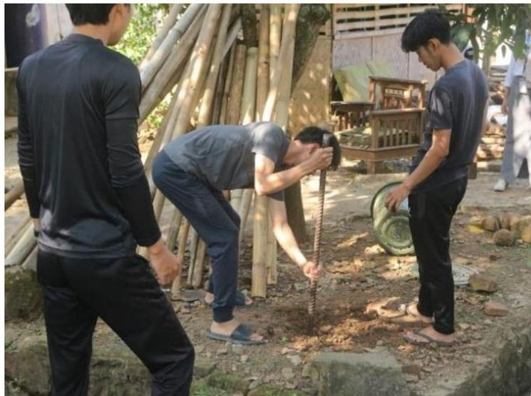
Gambar 1. Proses Pembuatan Lubang Biopori
